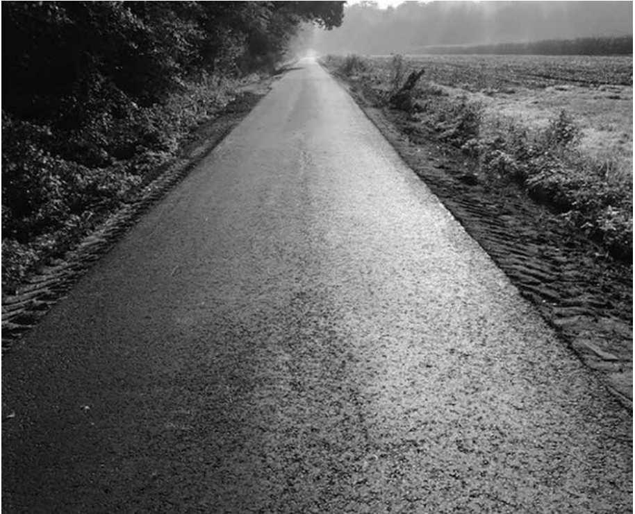
Leuvenheimse straat met nieuwe asfaltlaag 2 oktober 2020 foto Claire Vos
